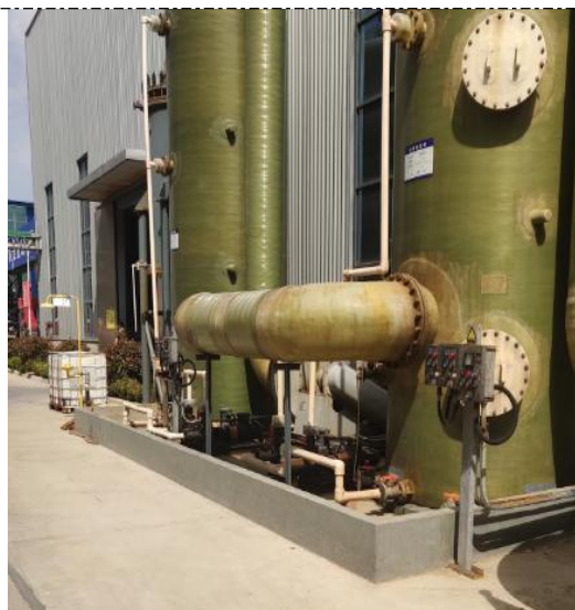
喷淋装置区围堰
