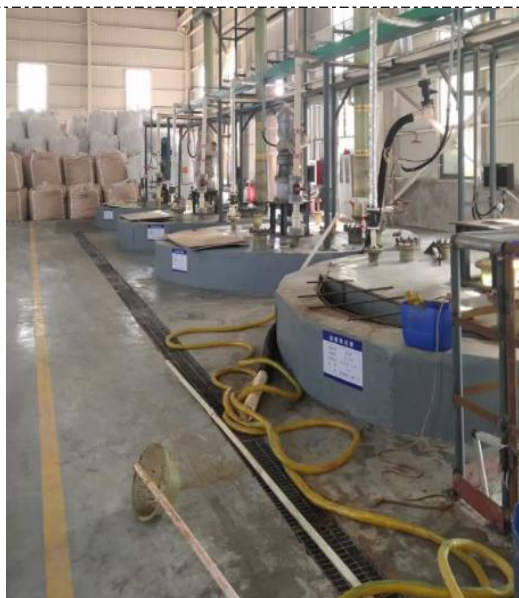
生产装置区导流沟
