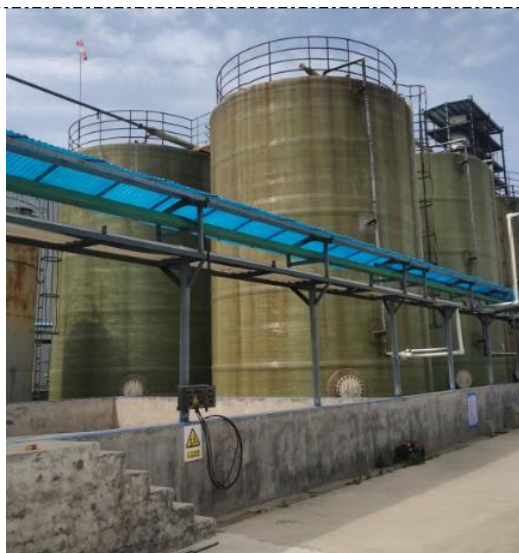
储罐区围堰
