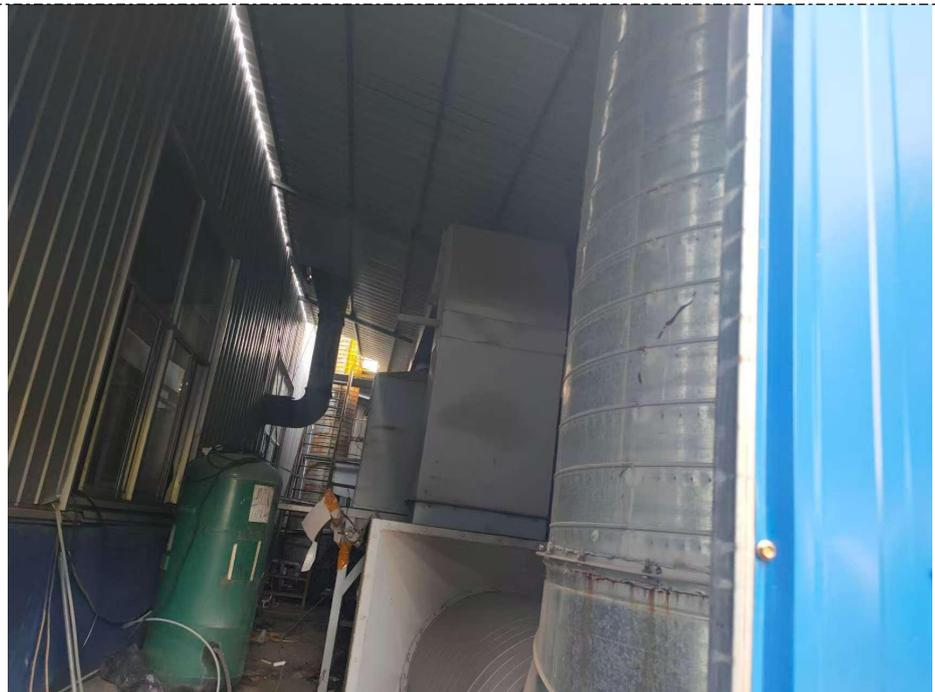
图 4-1 DA002 印刷烘干废气处理设施
