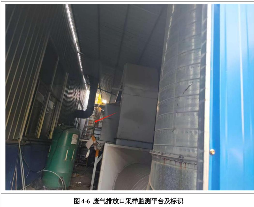
图 4-6 废气排放口采样监测平台及标识
