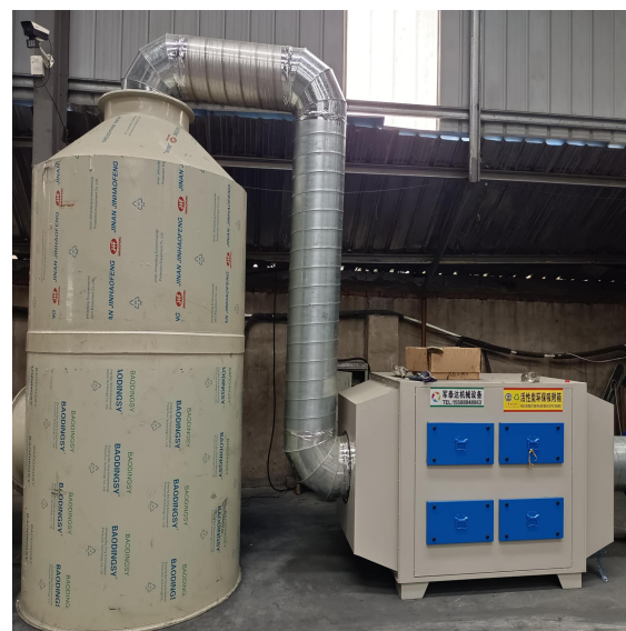
图 4-2 烘干工序喷淋塔、活性炭吸附装置
