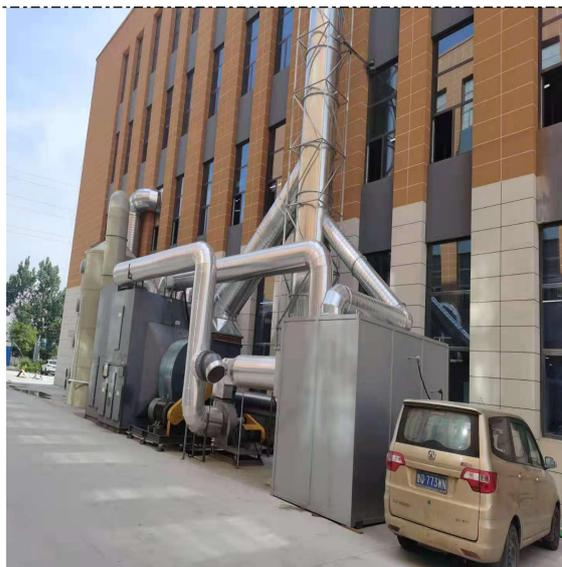
图 4-3 有机废气废气治理设施
