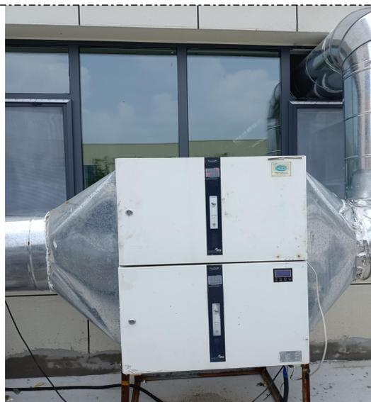
图 4-4 静电式油烟净化器
