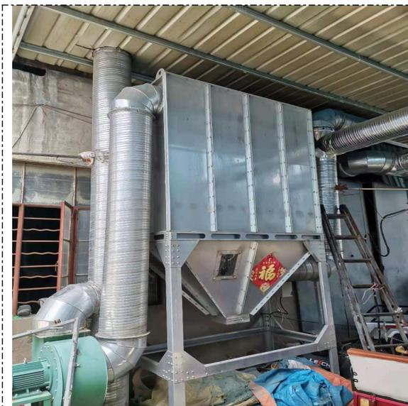
图 4-3 破碎废气除尘器
