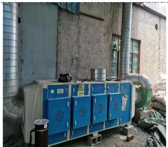
图 4-2 有机废气处理设施
