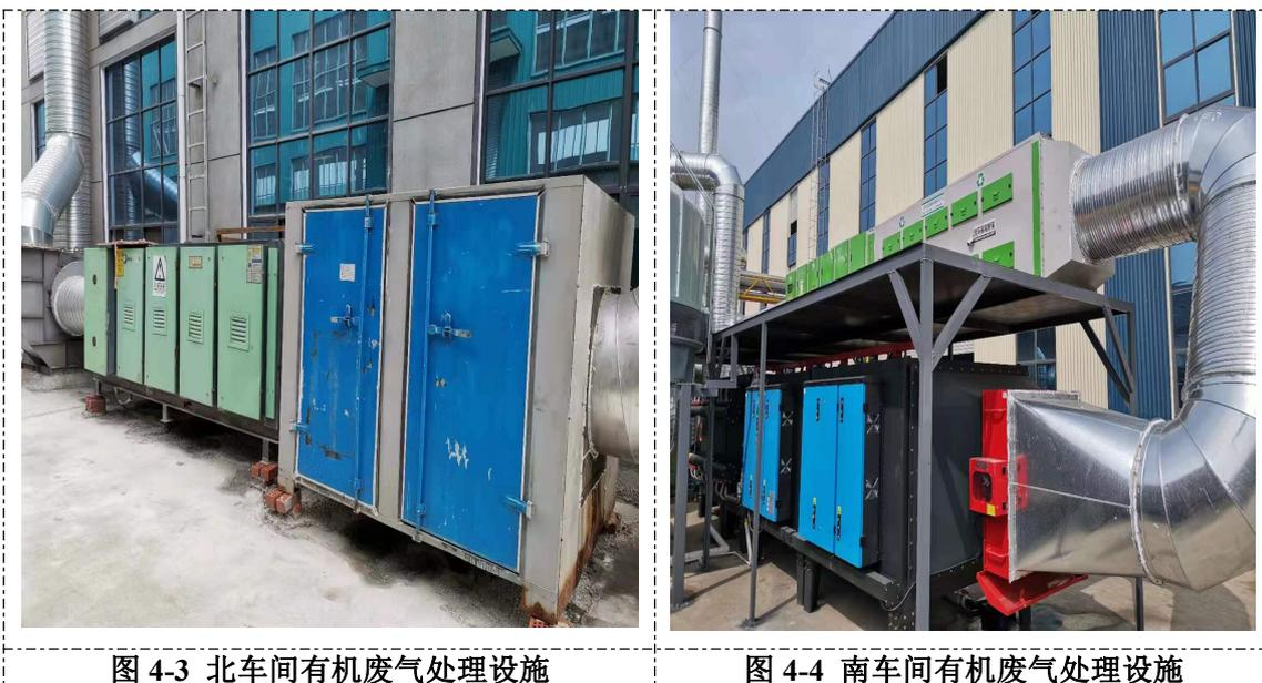
图 4-3 北车间有机废气处理设施
