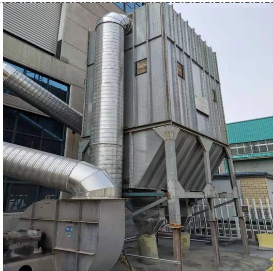
图 4-1 北车间脉冲除尘器
