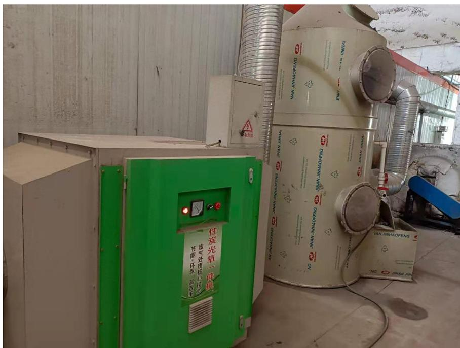
图 4-1 粉末喷涂固化工序环保设施
