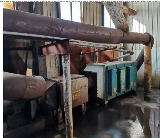
图 4-4 废气处理设施（光氧+油烟净化器）
