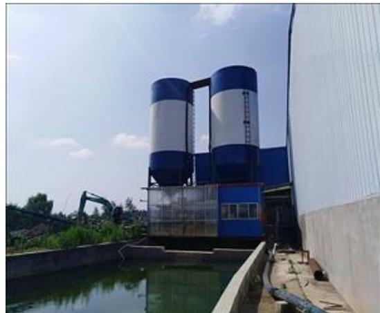
图 3-6 泥浆罐+压滤机+沉淀池
