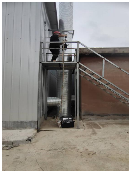
图 4-7 破碎筛分排气筒检测平台
