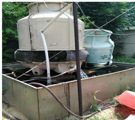
图 3-4 循环冷却水池
